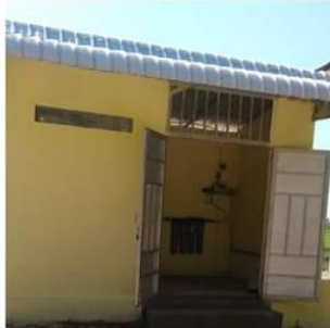
Local du traitement d'eau potable
