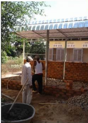
Construction du local de traitement d'eau potable
