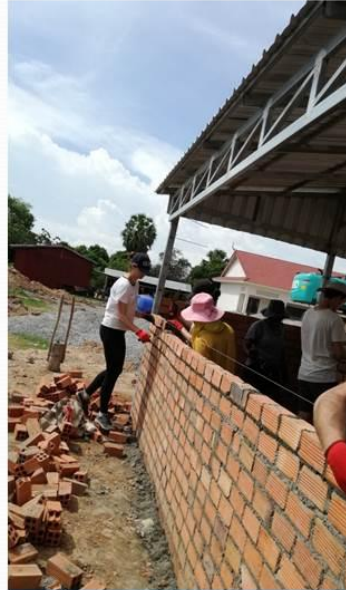
Construction du local de traitement d'eau potable
