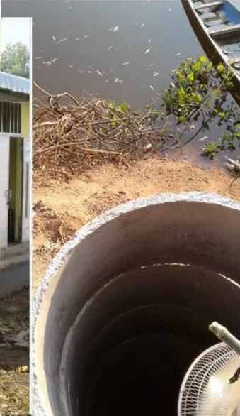
Puits de filtration d'eau de Rivière
