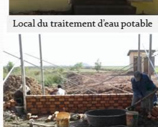
Construction du local de traitement d'eau potable
