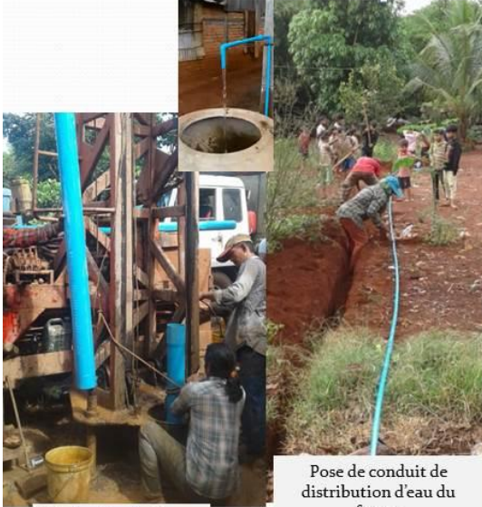
Réalisation du forage
